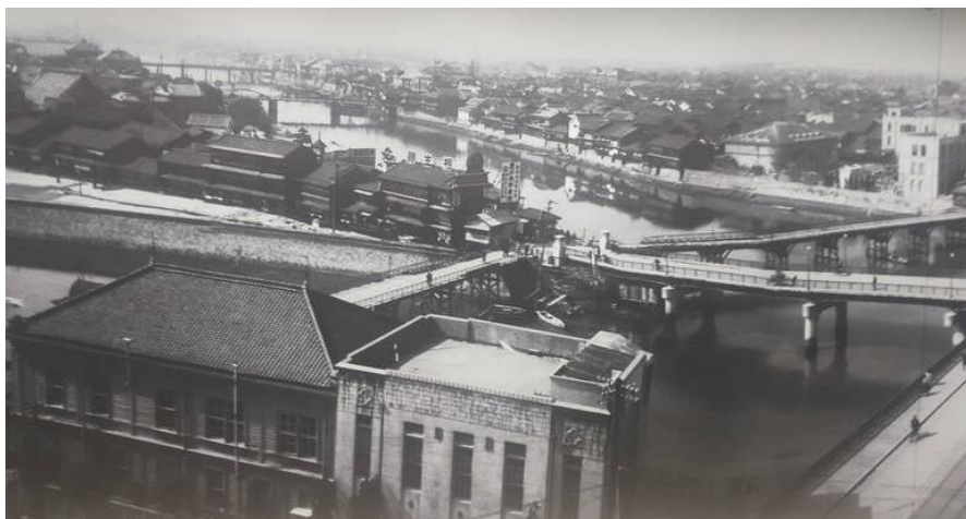
تصویری از مرکز هیروشیما (مسافرخانه‌های سنتی ژاپنی) پیش از انفجار اتمی (ضلعی از پل آیویی پیش از انفجار اتمی)
